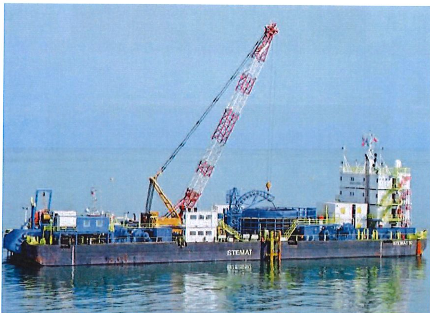
Photo 7 : barge posant des câbles
