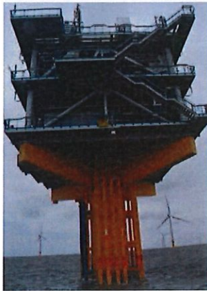
Photo 1 : exemple d'une sous-station électrique en mer
